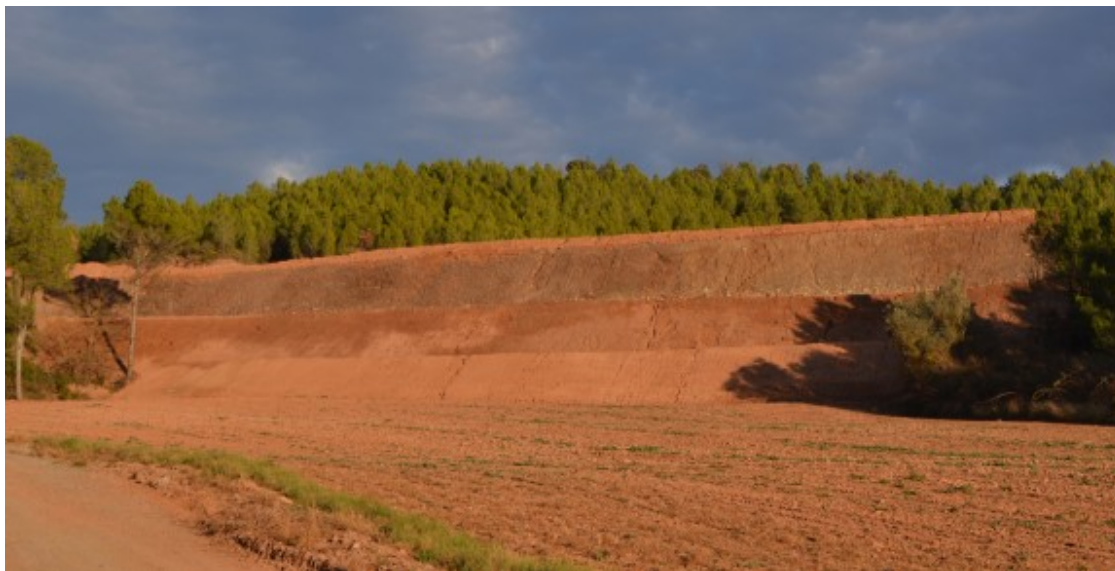
Vista lateral de l'abocador on es distingeixen les tres capes de terra. Foto: Pere Fontanals
